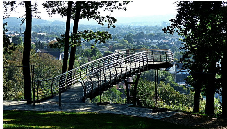
Skywalk im Nordpark
